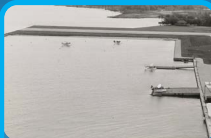
Construction de la première base torontoise d'hydravions civils et commerciaux.
