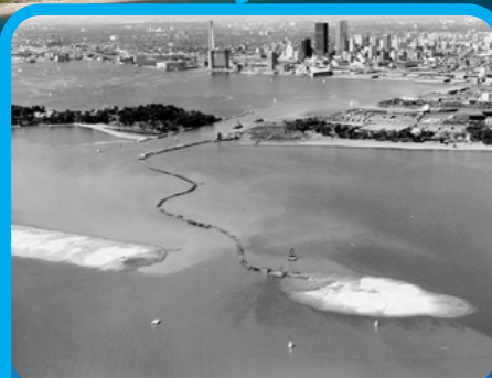
Construction de la flèche de la rue Leslie.
