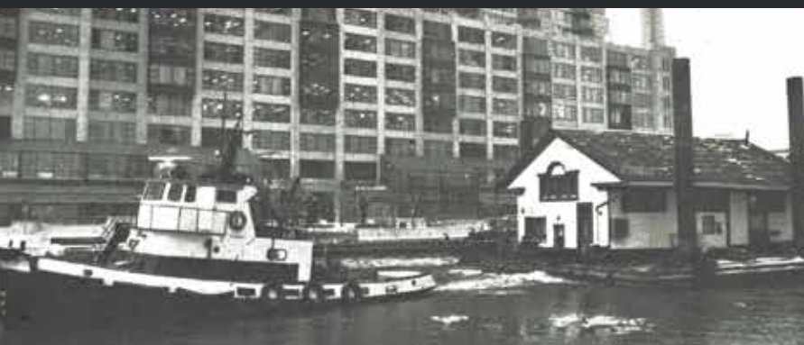
Ci-dessus : En 1988, la structure de la Jetée 6 fut placée sur une barge et remorquée à travers le havre de Toronto pour être ensuite entreposée pendant la réalisation des travaux de construction des nouvelles fondations.
